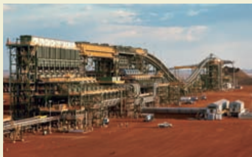
Jimblebar鉄鉱山の鉄石処理設備（提供元：BHP Billiton社）
