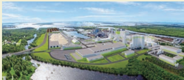
(METSA FIBRE OY社 KEMI工場の増産ライン完成時イメージ)
