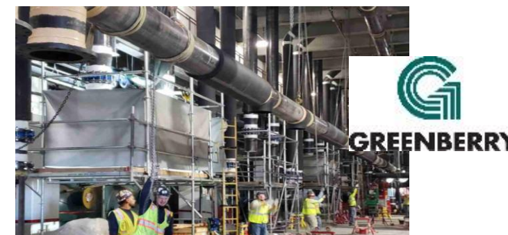
配管製造・据付工事
