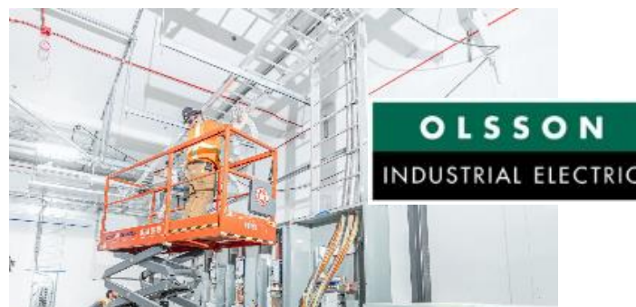
電気設備機器供給・工事
