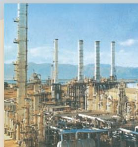
アルジェリアに建設した 石油化学コンビナート
