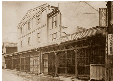
二代目伊藤忠兵衛が建築した日本初の鉄筋コンクリート造りの倉庫 1910年、二代目忠兵衛は、イギリスから持ち帰った鉄筋コンクリート建築に関する図書をもとに、日本初の鉄筋コンクリート造りの倉庫を建築しました。
