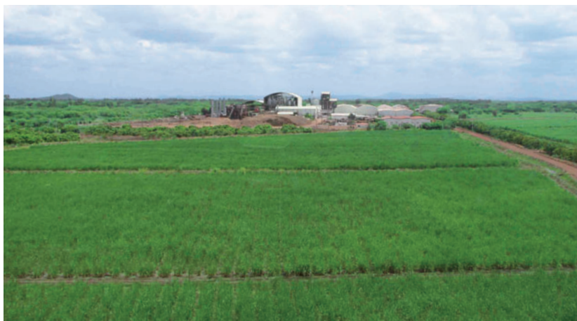
バイオエタノール工場
