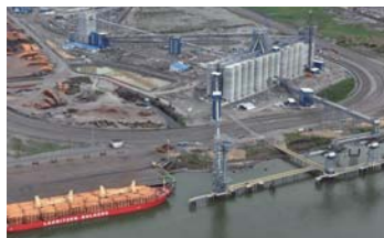
EGT：北米西海岸穀物輸出ターミナル
