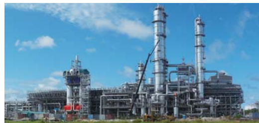
プラント外観
