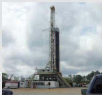
石油・ガス開発現場
