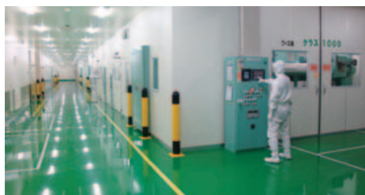
最新設備のCleanroom塗工機（茨城工場）
