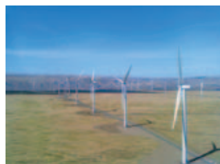
シェファード・フラット発電所
