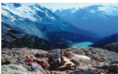
地表ボーリング現場の様子
