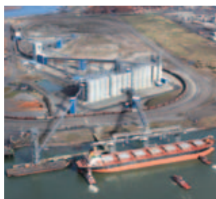
北米西海岸穀物輸出ターミナル
