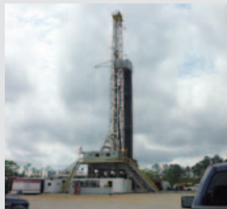
石油・ガス開発現場
