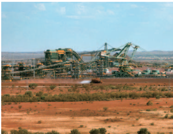
ジンブルバー鉄鉱山の鉱石処理設備 (BHPビリトン社提供)
