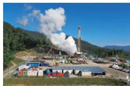
プロジェクト建設現場
