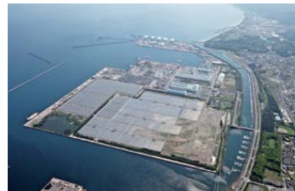
大分日吉原太陽光発電所全景
