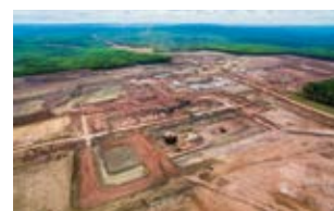
原油処理施設の建設現場
