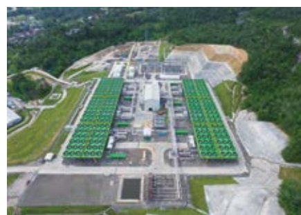
サルーラ地熱発電所1号機
