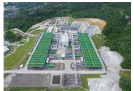
サルーラ地熱発電所1号機
