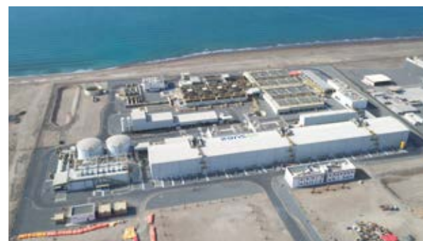
オマーンのバルカ海水淡水化プラント
