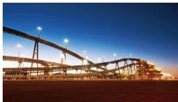
西豪州鉄鉱石事業の鉱石処理プラント(BHP 社提供)
