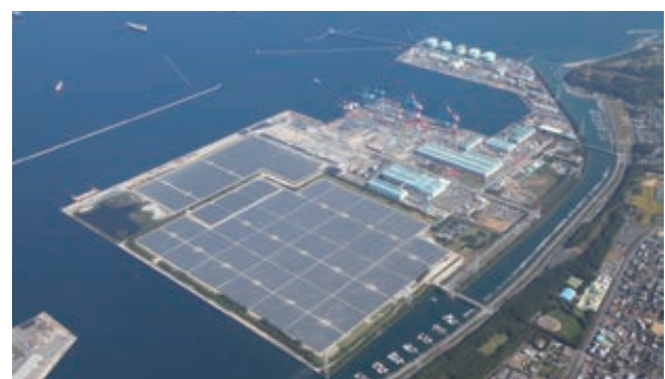
大分日吉原太陽光発電所全景
