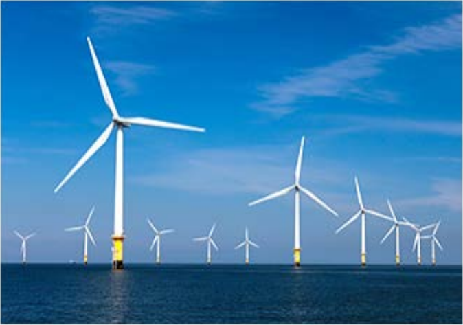
Butendiek風力発電所
