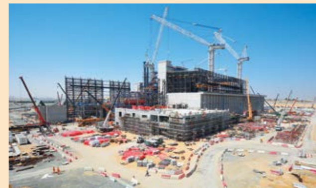
ドバイ廃棄物処理発電プラントの建設状況
