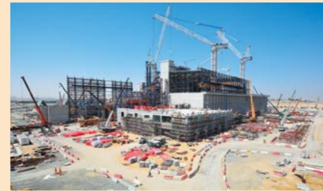
ドバイ廃棄物処理発電プラントの建設状況
