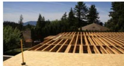
Pacific Woodtech社製単板積層材を使用した住宅用構造材
