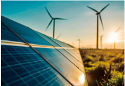
風力・太陽光発電所
