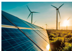
風力・太陽光発電所
