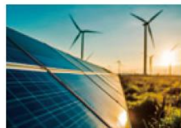
風力・太陽光発電所
