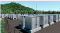
福岡県で建設中の大規模蓄電所
