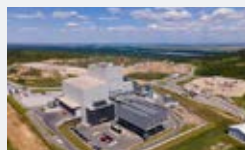
セルビアの廃棄物処理発電施設
