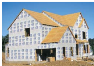
北米の住宅建築現場 —PrimeSource社等が資材を供給
