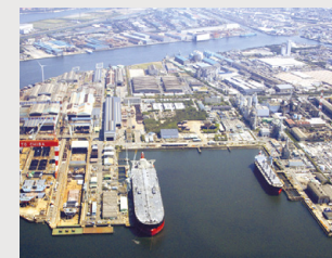
建設予定地 (三井造船(株) 千葉事業所構内)
